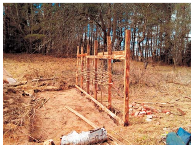
Снятие дёрна, установка основы каркаса
